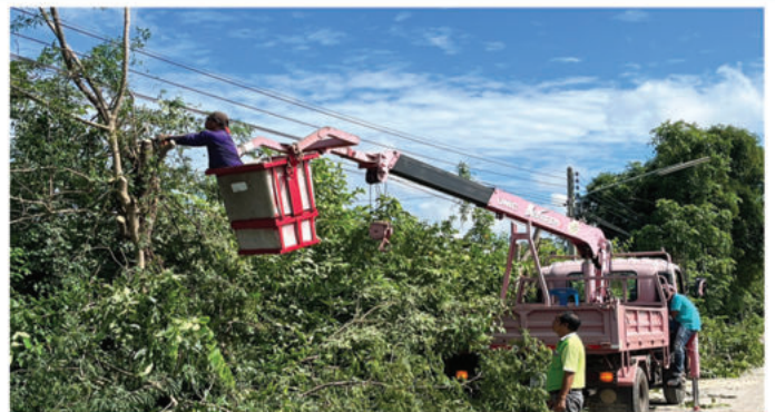
เจ้าหน้าที่งานป้องกันฯ สำนักปลัดเทศบาล เจ้าหน้าที่กองช่าง และเจ้าหน้าที่ กองสาธารณสุข ดำเนินการตัดต้นไม้ริมทางสัญจรในเขตตำบลโนนสูง
